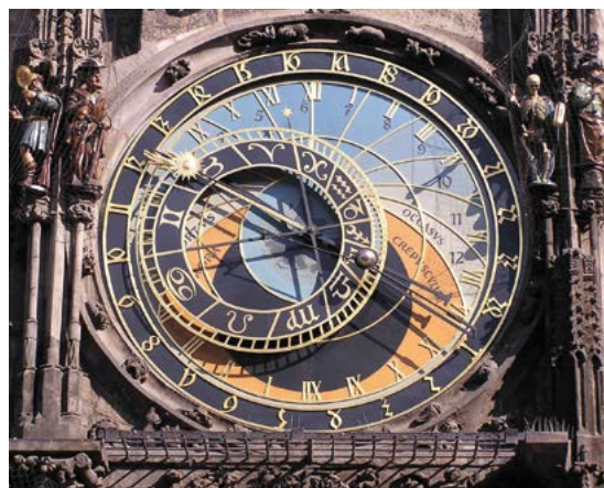
Obr. 1 Astronomický ciferník pražského orloje před rekonstrukcí. Uprostřed je znázorněná Země a kolem ní jsou koncentricky umístěny tři kružnice reprezentující postupně od středu oběžná dráha Kozoroha, nebeský rovník a oběžná dráha Raka doplněná římskými čísly. Foto: Michal Křížek
